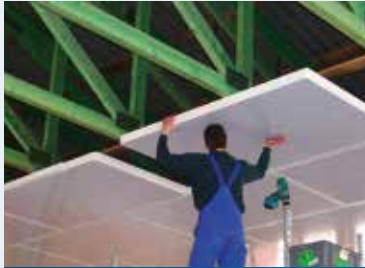
Montagearbeiten rund um die Stallklimatisierung
