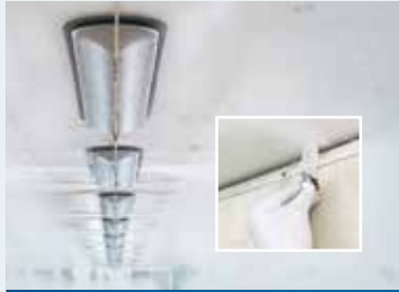
Optimierung der Stalllüftung
